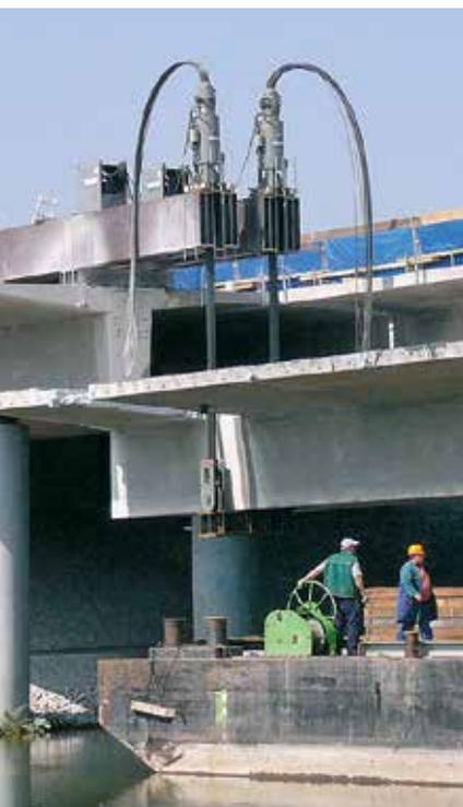
Tonnenschwere Lasten zu bewegen ist eine Sache. Tonnenschwere Maschinen, Turbinen, Transformatoren, Generatoren oder Brückenbauteile mit absoluter Präzision zu heben, zu drehen, abzusenken und für eine Montage so exakt auszurichten, dass zum Beispiel einzelne Elemente zur sicheren Montage millimetergenau miteinander verschraubt werden können: Das sind Aufgaben, die nur mit unserer Litzenhebertechnik zu lösen sind.
