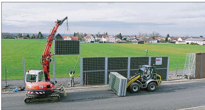
Die Lärmschutzwände sind schnell auf- und wieder abgebaut.
